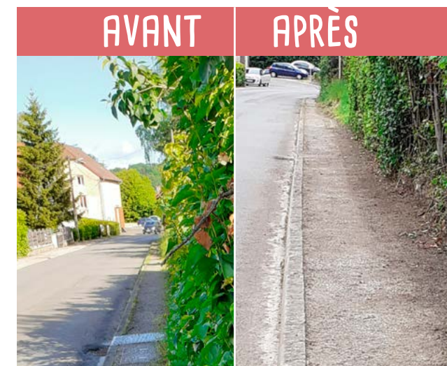
NETTOYAGE DE 150M DE TROTTOIRS
