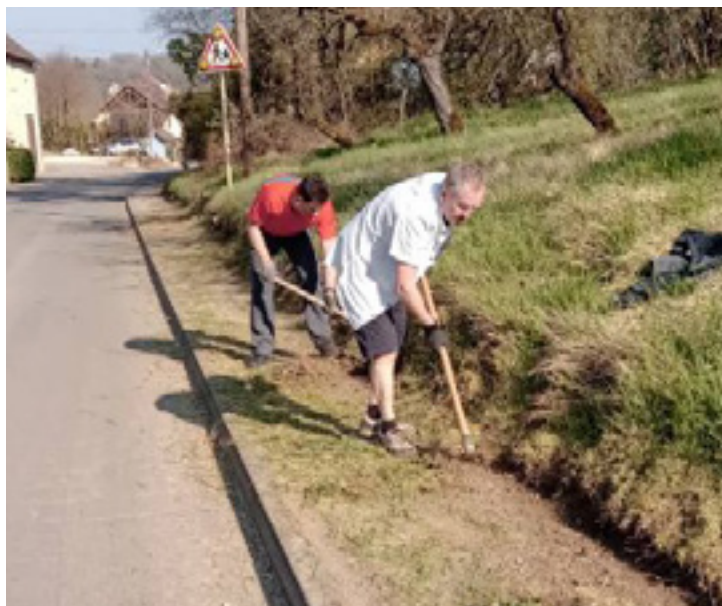
DÉCAPAGE DES TROTTOIRS
